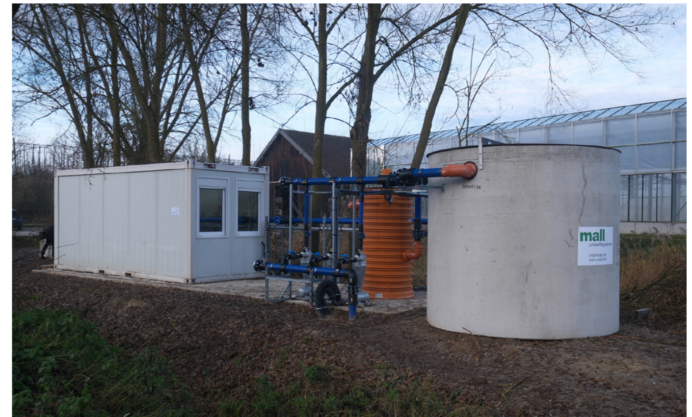
Abb.6 Smart-SWS Pilotanlage zur künstlichen Grundwasseranreicherung in der Hallertau (©L. Augustin, 18.12.2024)
