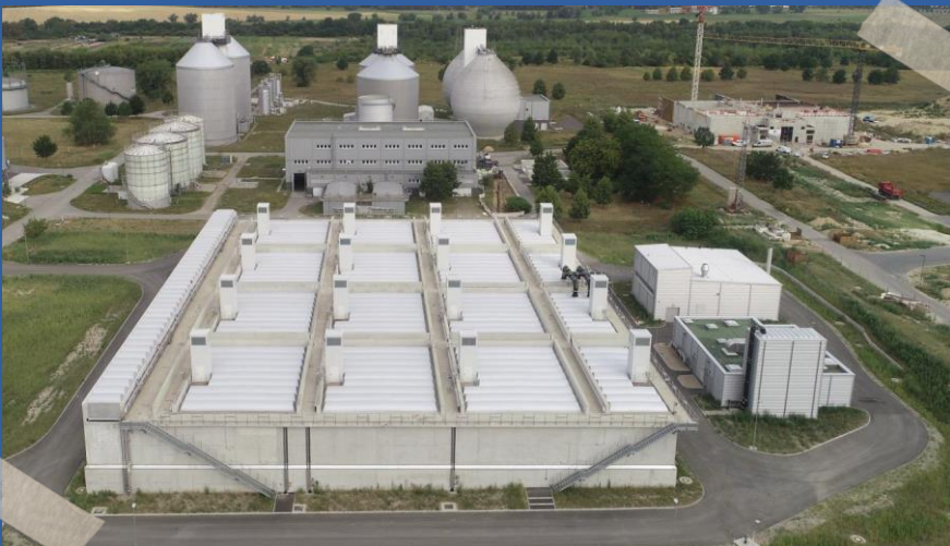
Luftbild vom fertiggestellten Mischwasserspeicher im Sommer 2020 (© BwB)
