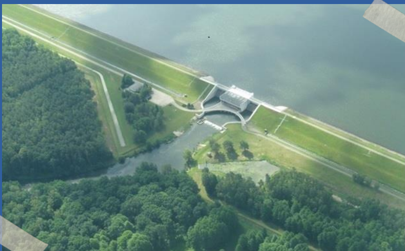
Talsperre Spremberg mit Grundablass- und Entlastungsbauwerk, Juni 2016 © W25/Landesamt für Umwelt
