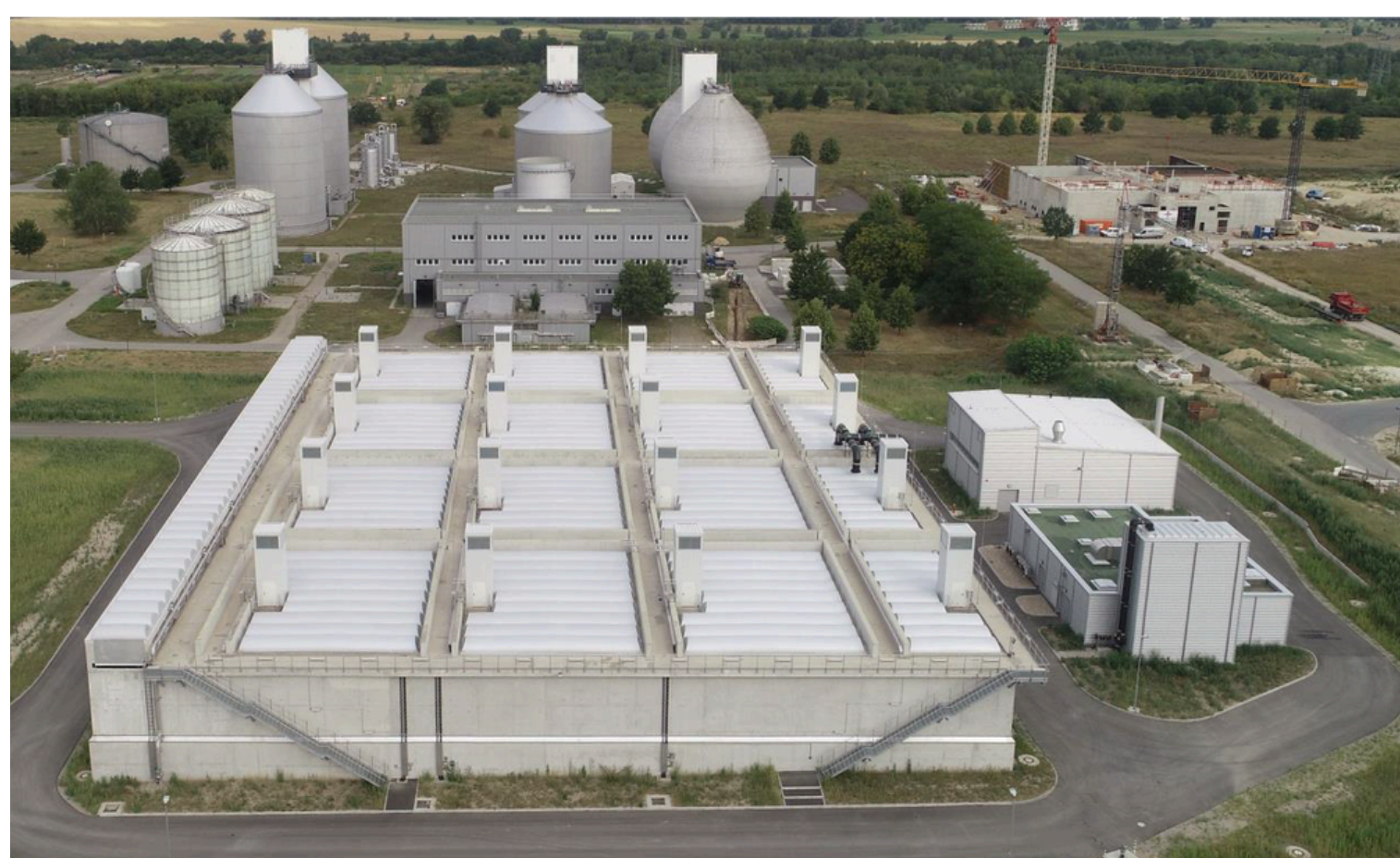
Abb. 1: Mischwasserspeicher Waßmannsdorf (bei Berlin) (© BWB)
