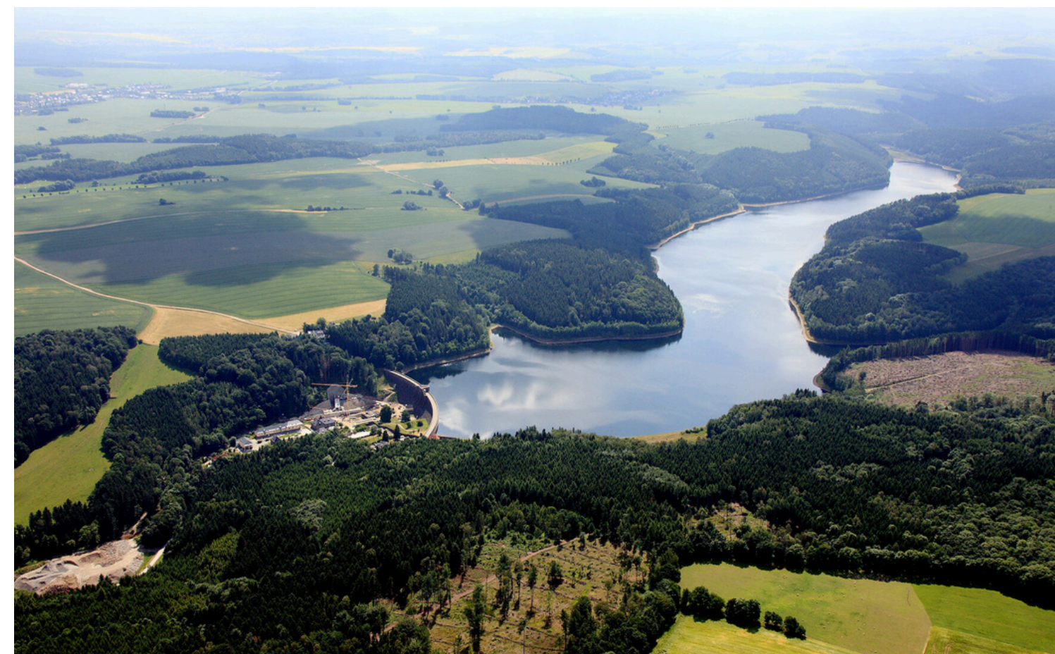
Abb. 2: Talsperre Klingenberg (© Landestalsperrenverwaltung Sachsen / Luftbild: Peter Schubert)
