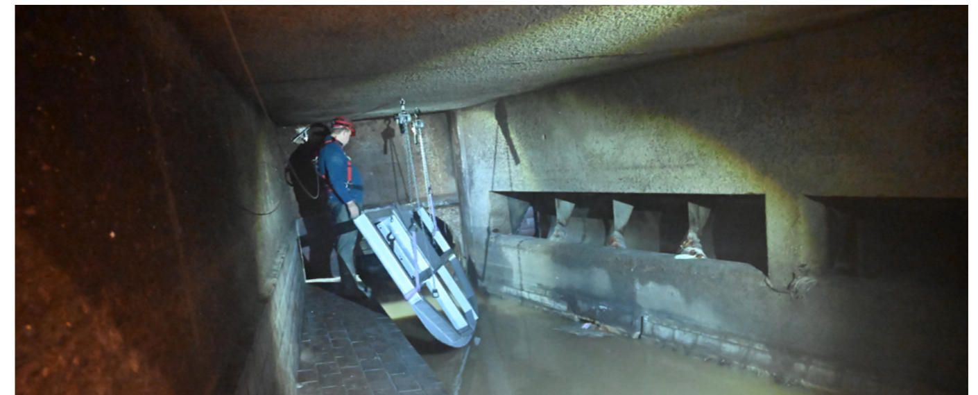
Abb.10 Einbau eines steuerbaren Klappensystems im Jenaer Kanalnetz (©HST)
