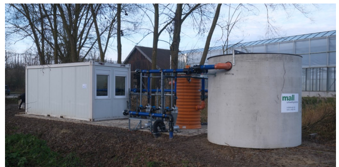
Abb. 6: Smart-SWS Pilotanlage zur künstlichen Grundwasseranreicherung in der Hallertau (© L. Augustin, Smart-SWS)
